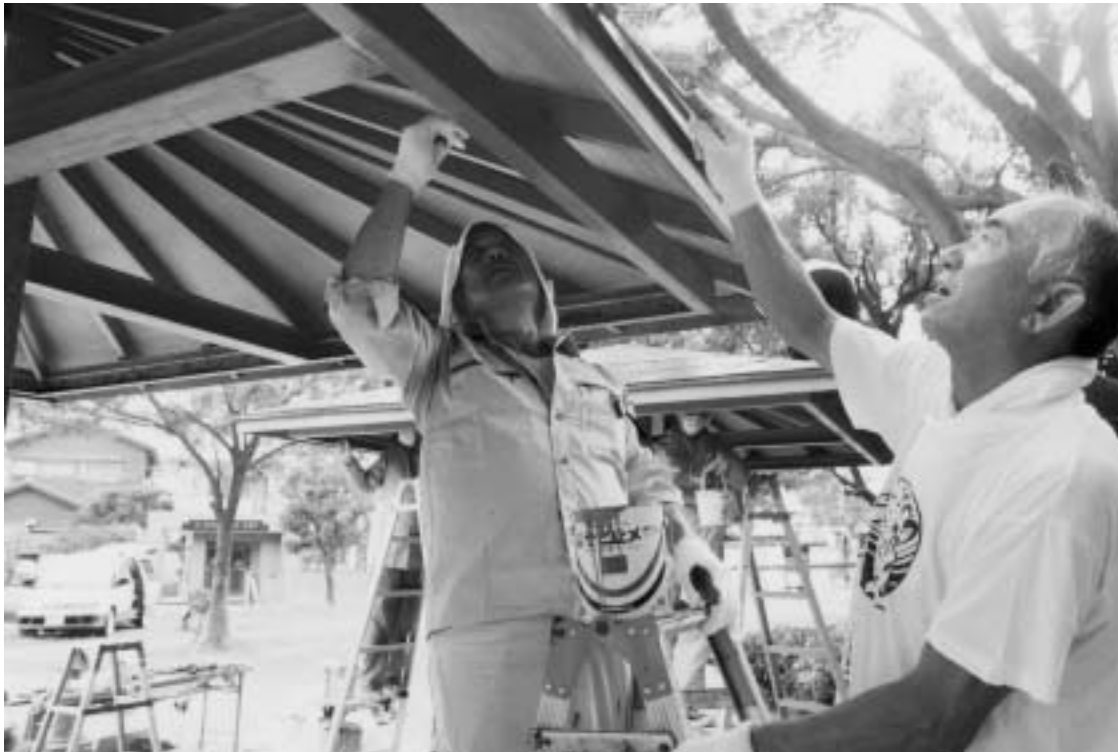
もれのないようにいねいにサビ止めを塗る自治会のメンバー
